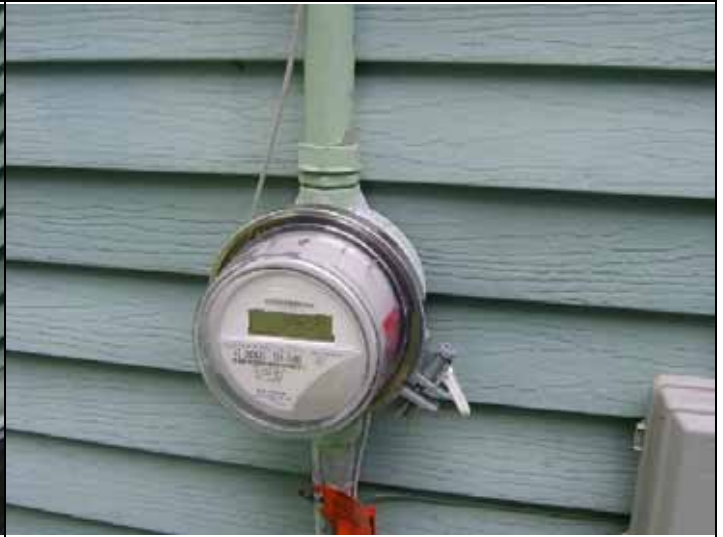
60 amp meter socket
